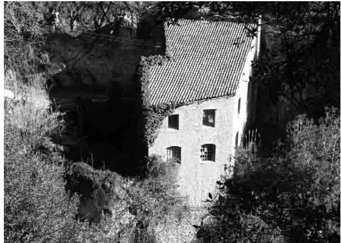
Foto 3: Edifici que es conserva actualment de l'antiga filatura de ca l'Alert al Pèlag del Roquer.
