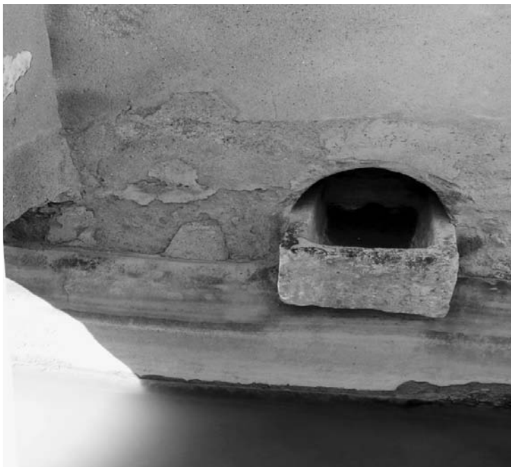
Gràfic 10: Pica per conduir l'aigua del rec cap els clots.
