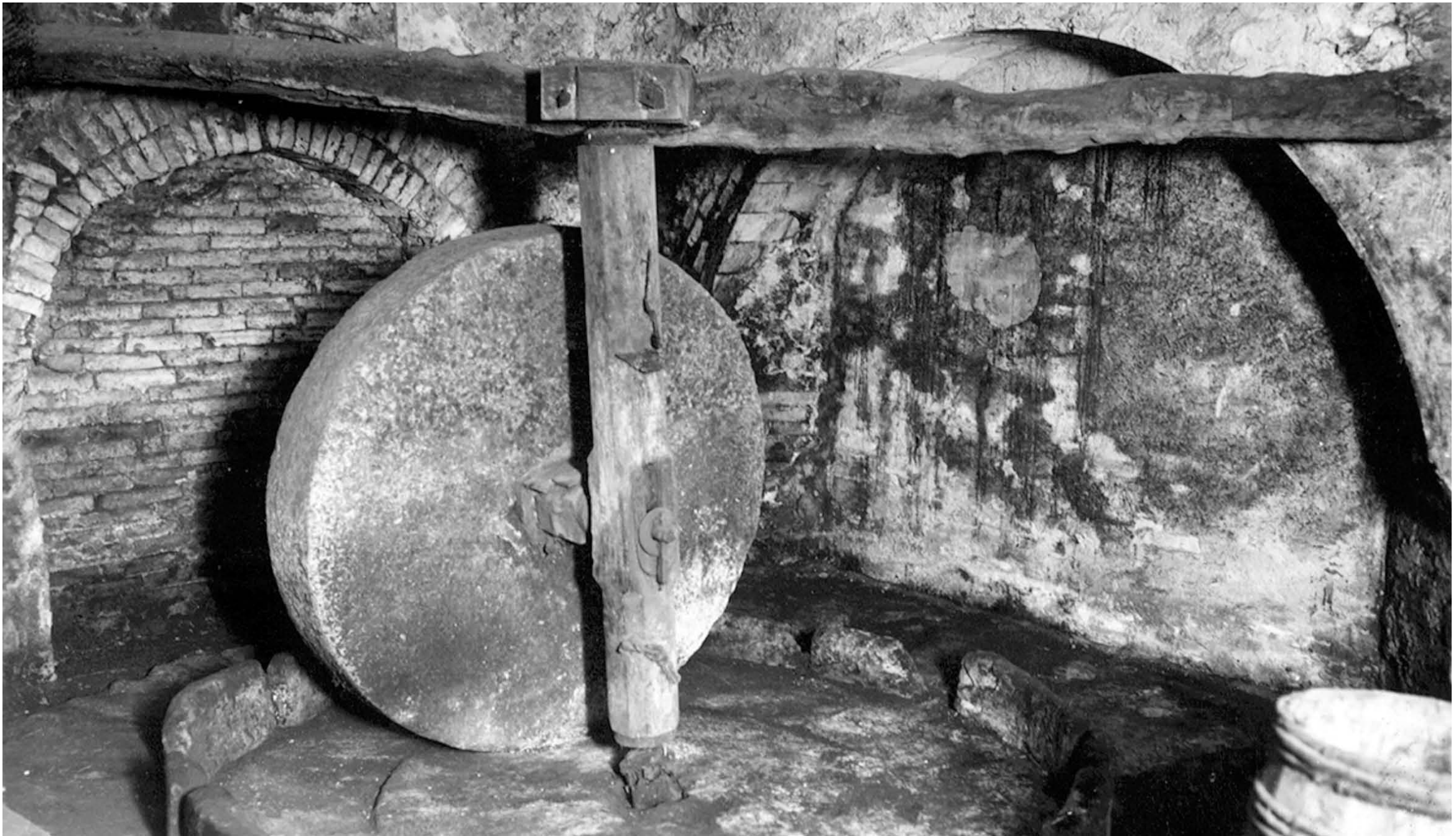
Gràfic 11: Molí de tracció animal (o corró) de productes vegetals adients per a l'adob de pells.
