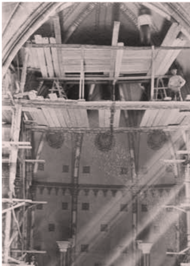
Treballs de reconstrucció del temple de la Soledat, la reobertura del qual no podrà celebrar-se fins el setembre de 1944
