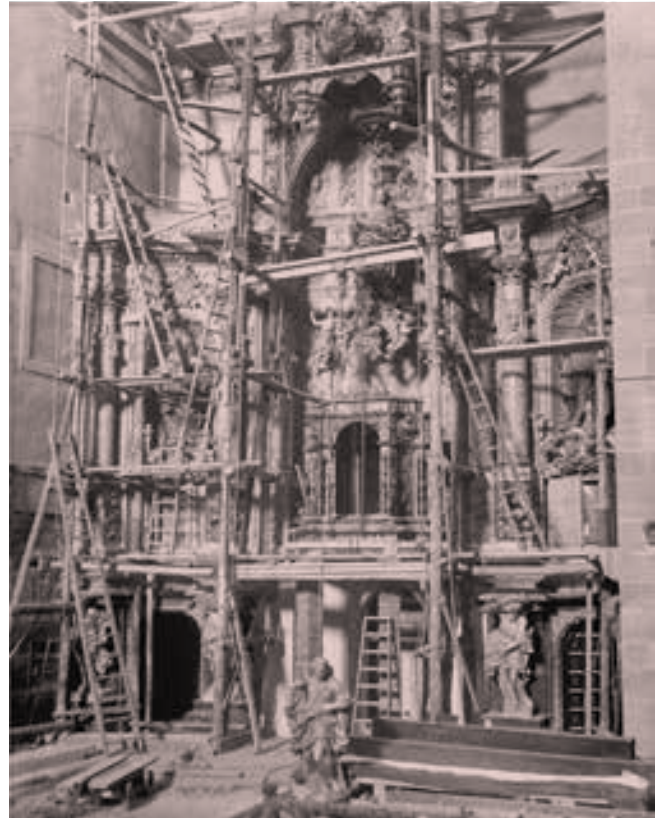
Reconstrucció del retaule major de l'església de Santa Maria. Una feina laboriosa delicada i artesanal, que per la seva complexitat s'allargà fins a 1947
