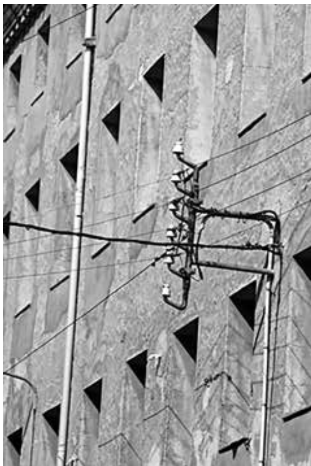
Les finestres disposades en perfecte simetria possibilitaven una bona il·luminació de la fàbrica (CECI, Miquel Martínez)
