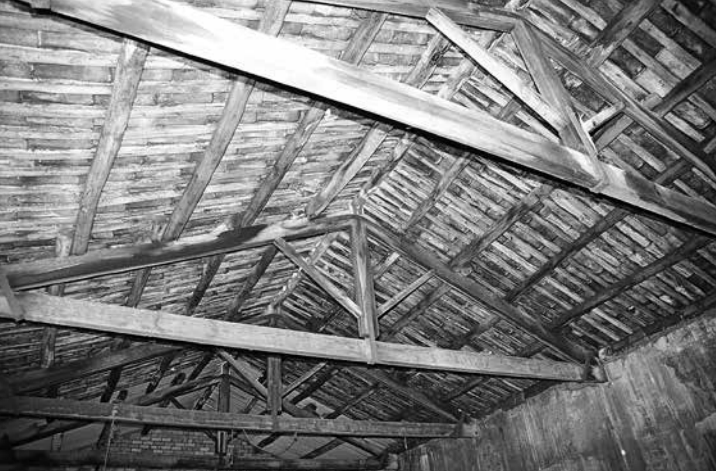
Encavallades de suport de les cobertes (Ajuntament d'Igualada)
