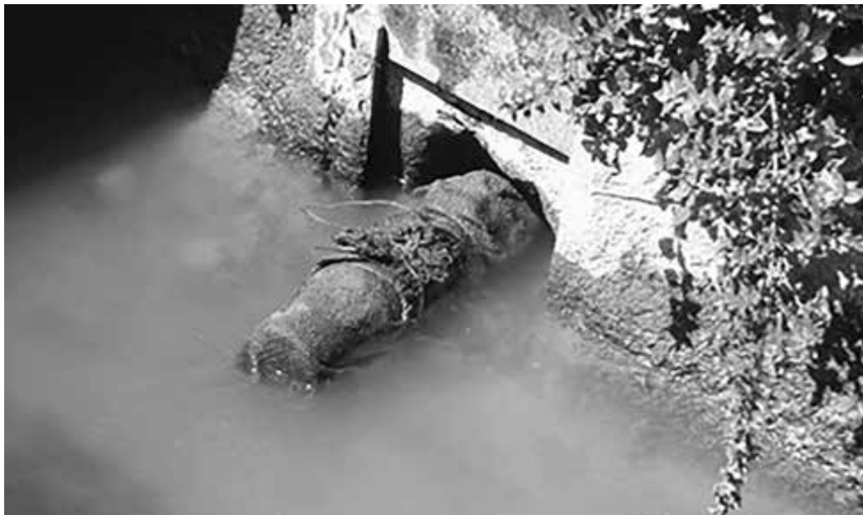
Boixa per tapar els forats (boixerreres) a través dels quals els usuaris captaven l'aigua del Rec per a usos agrícoles o industrials (CECI, procedent de Magí Puig)
