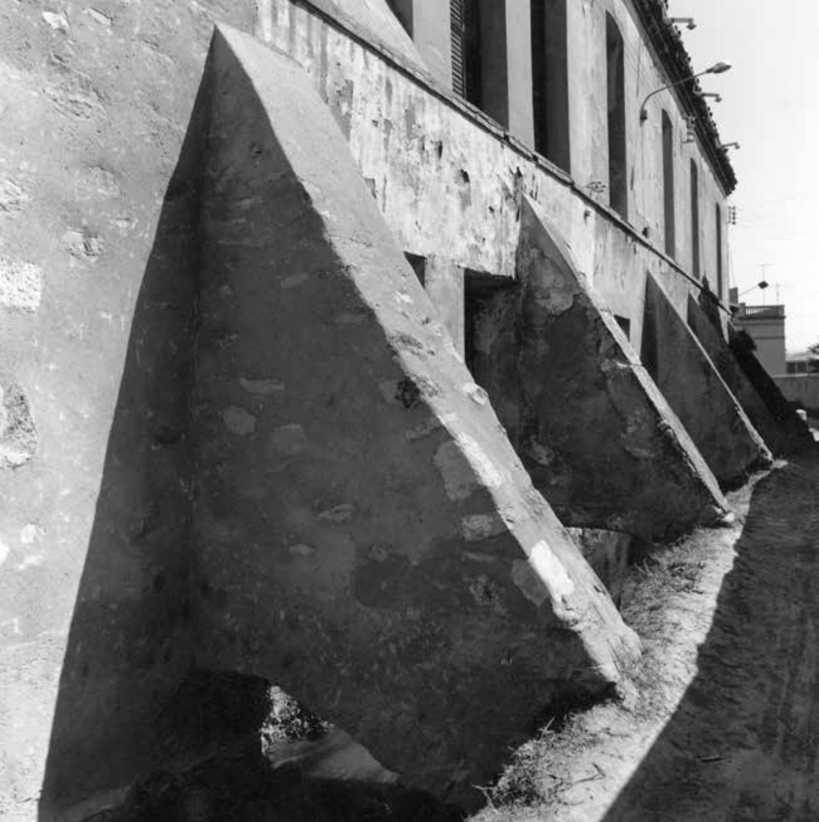
Contraforts de recolzament de les façanes de les adoberies al llarg del camí del Rec (ACAN-AMFI)
