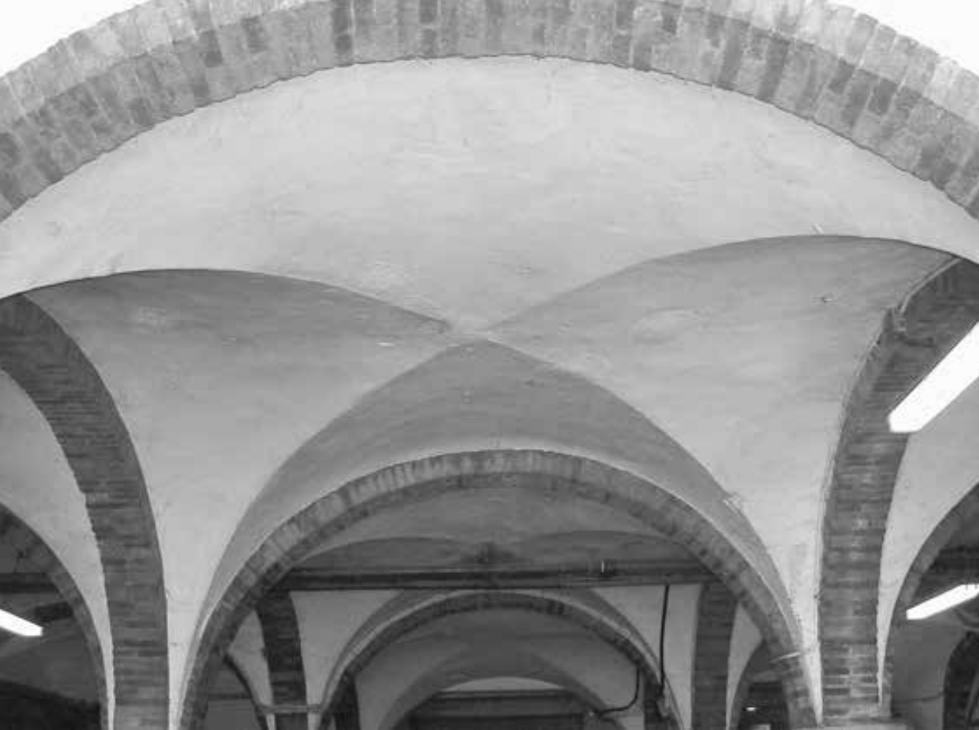
Voltres d'aresta del sostre de l'adoberia de cal Maco (CECI, Pilar Cuerva)
