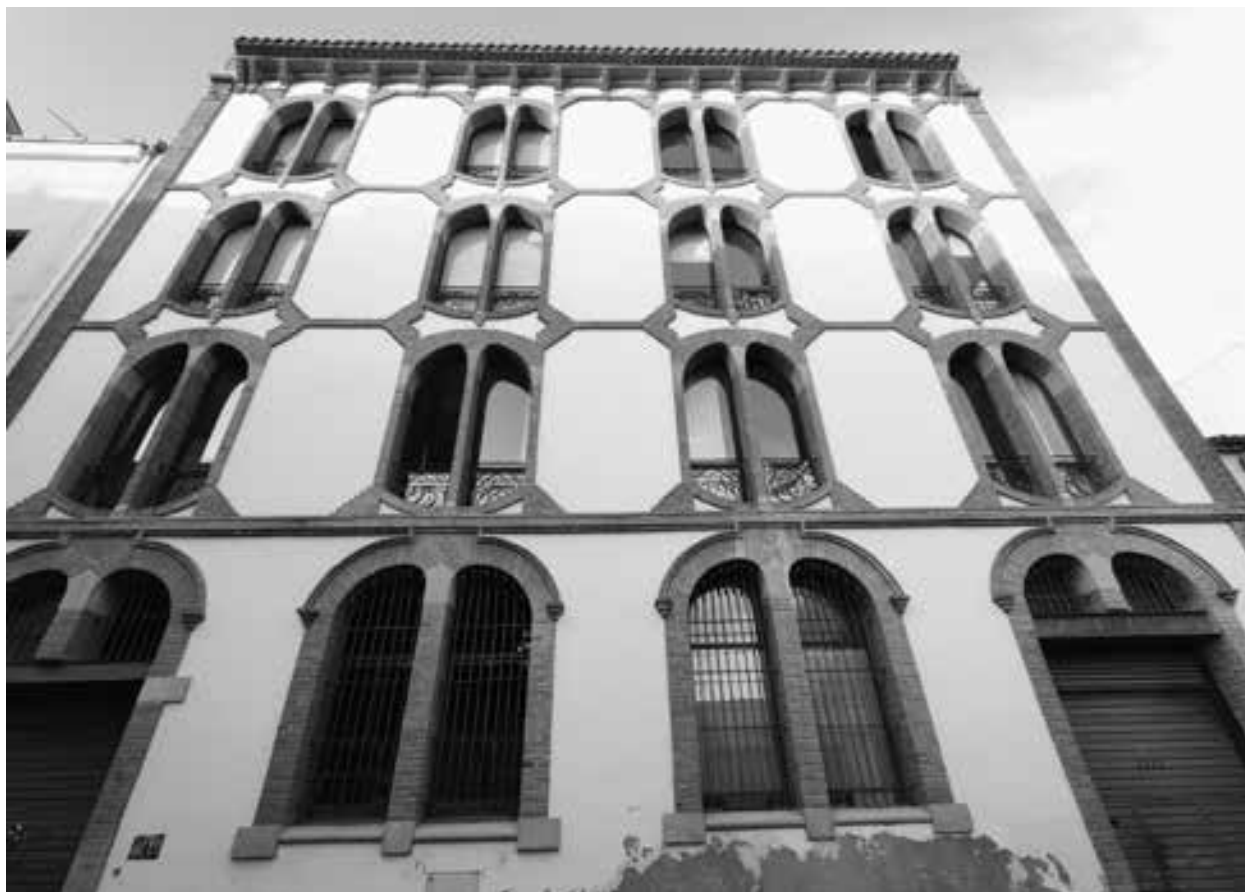
Façana modernista de l'antiga adoberia de Josep Pelfort al carrer de Sant Antoni de Baix (CECI)
