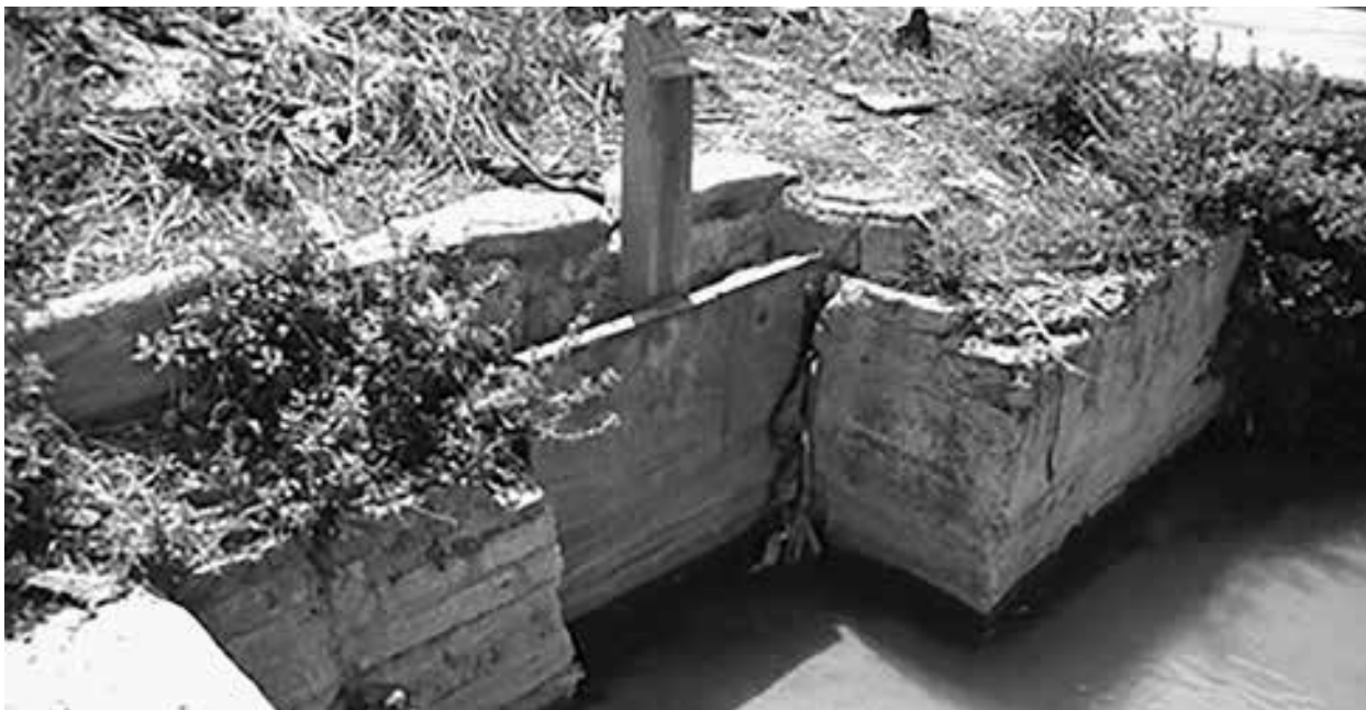
Bagant o comporta que tapava les clavegueres emprades pel desguàs de l'aigua del Rec vers el riu (CECI, M. Solà Rossell)
