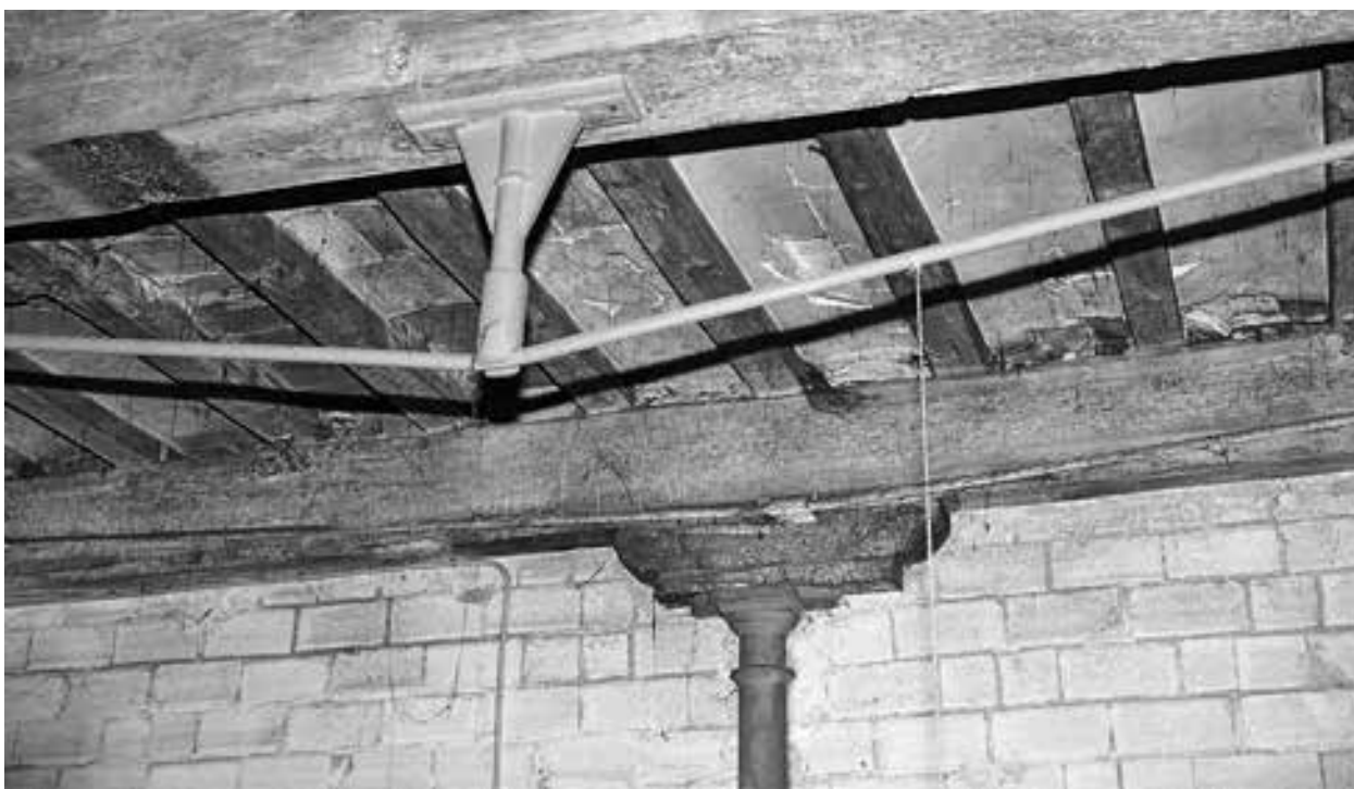
Els sostres a base de revoltons amb bigues de fusta sostinguts per grans jàsseres i columnes de ferro colat (Ajuntament d'Igualada)
