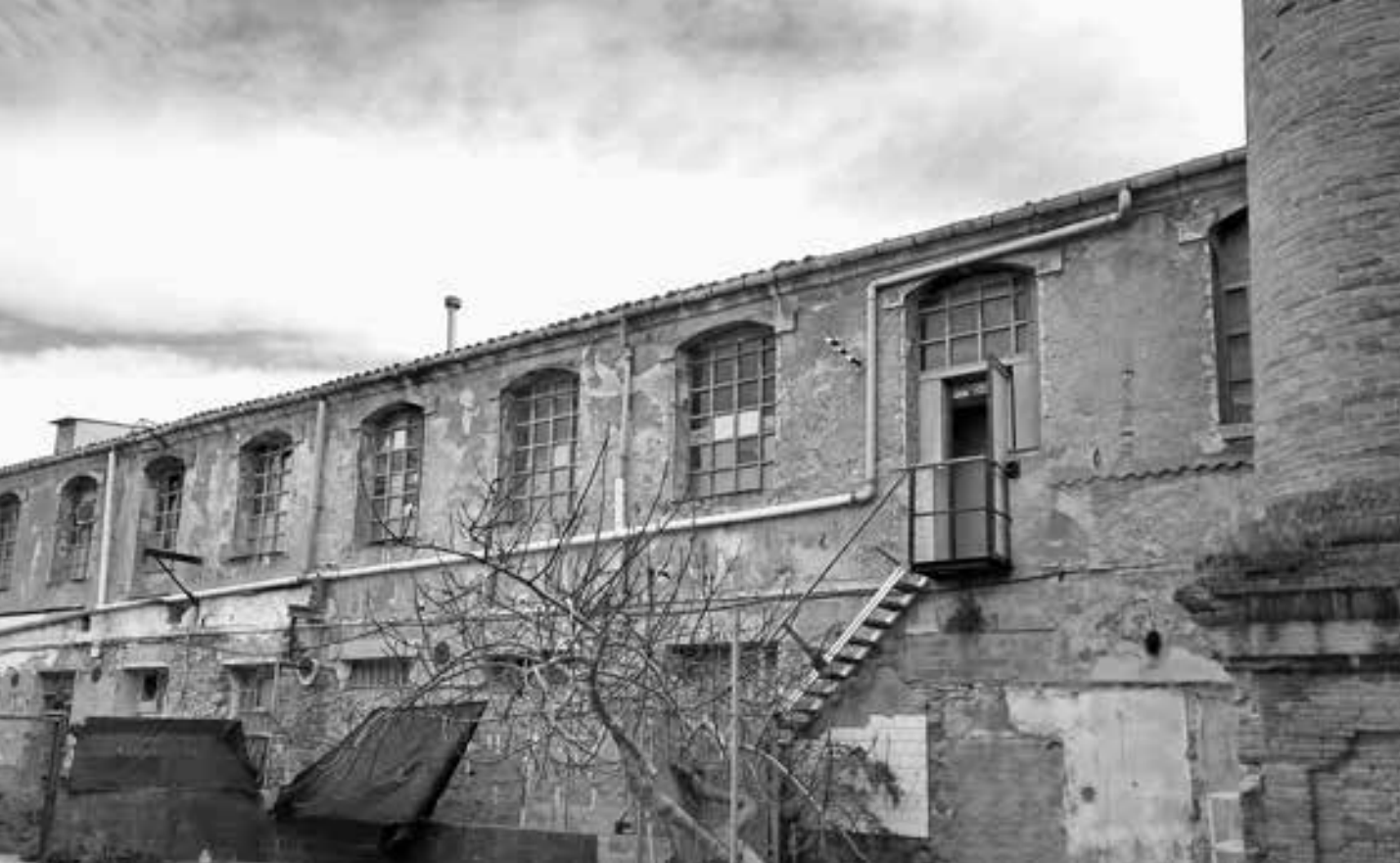
Estat actual de la façana occidental de l'antic "Vapor de Baix" (CECI. Gemma Estrada)
