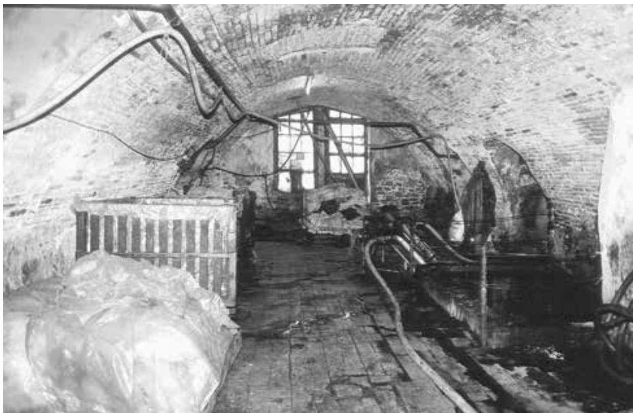
Una de les dues naus cobertes amb volta de canó seguit de la planta subterrània de l'antiga adoberia de Josep Tous (CECI)
