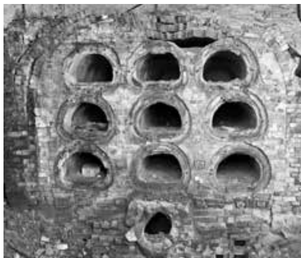
Antigues retortes de la fàbrica de gas. CECI. Miquel Térmens
