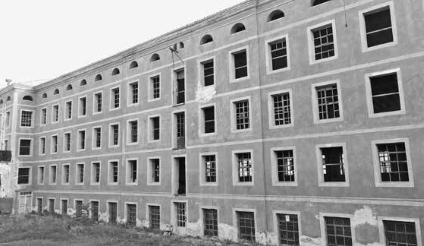
Façana septentrional de la Igualadina després de les obres de rehabilitació externa (CECI)
